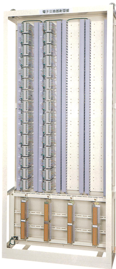
施工例：文部科学省金沢大学電子交換機用耐雷盤
