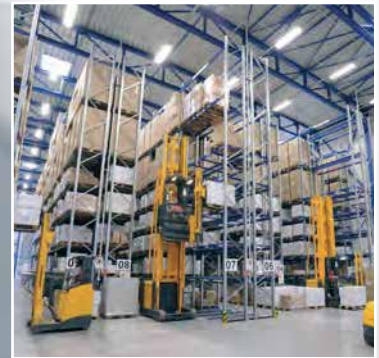
物流倉庫をオートメーション化。 全自動梱包出荷システムを導入。
