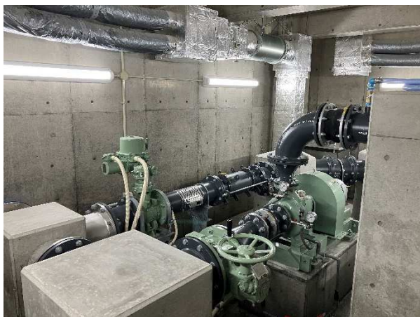
茅野市埴原田配水池に設置された小水力発電設備外観
